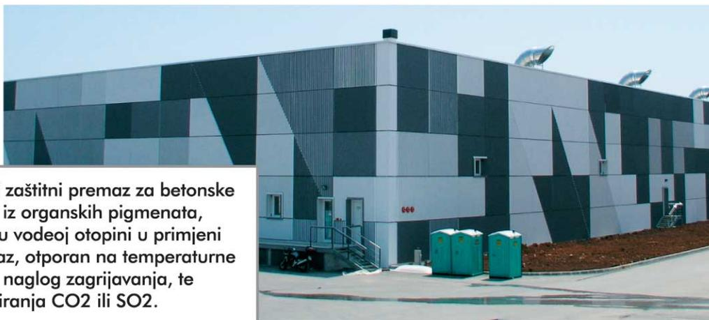
BETONCRYLL je specijalni akrilni zaštitni premaz za betonske i cementne površine. Pripremljen iz organskih pigmenata, pokrivnih punila i akrilnih smola u vodej otopini u primjeni stvara zaštitni vodoodbojni premaz, otporan na temperaturne cikluse od naglog smrzavanja do naglog zagrijavanja, te izuzetnu zaštitu površine od prodiranja CO2 ili SO2.
